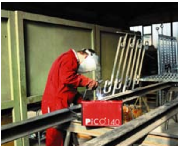
Bild 22 Anwendung des E-Hand-Schweißens beim Geländerbau
