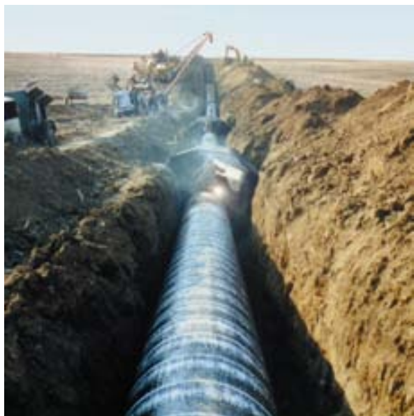
Bild 6 Schweißen im Rohrleitungsbau mit Zellektroden
