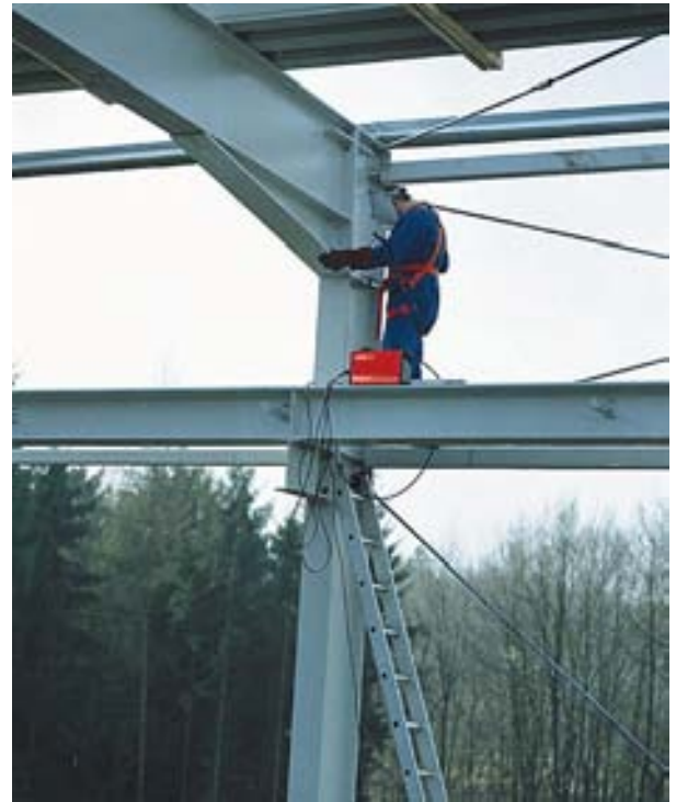
Bild 20 Einsatz der Inverter-Schweißstromquelle PICO 162 auf der Baustelle
