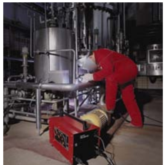
Bild 24 TIG 230 DC, WIG-Schweißen in der Lebensmittelindustrie
