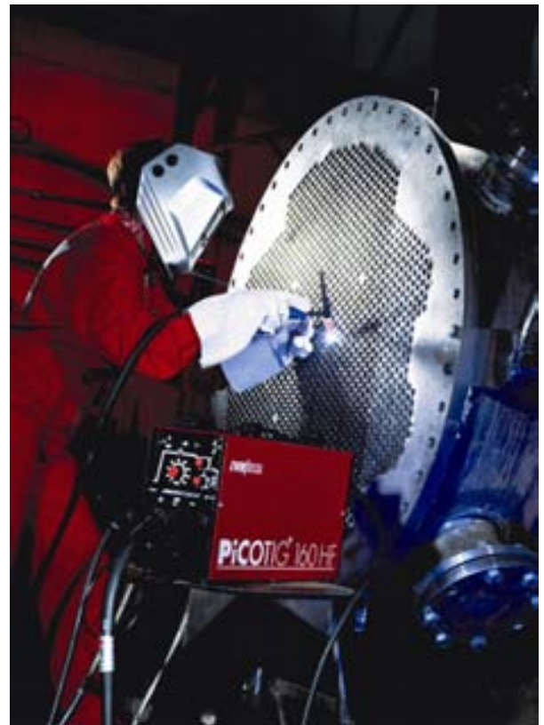
Bild 32 WIG-Schweißen beim Einschweißen von Rohren in Rohrböden
