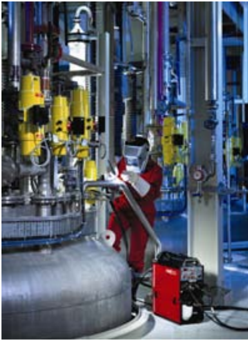
Bild 30 TRITON 260 DC, WIG-Schweißen an Rohrleitungen
