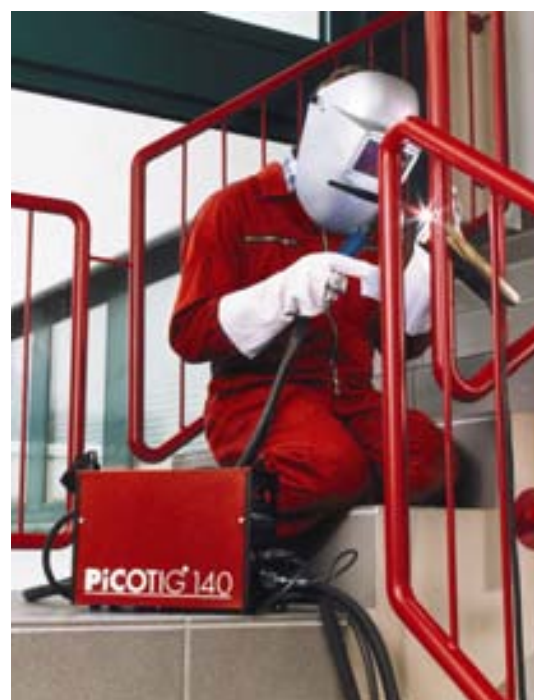
Bild 4 WIG-Schweißen an einem Geländer
