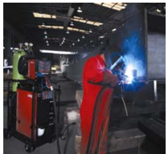
Bild 38 MAG-Schweißen an Trägern im Stahlbau
